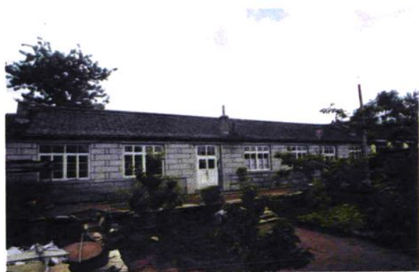
祁义故居翻建后的房屋
