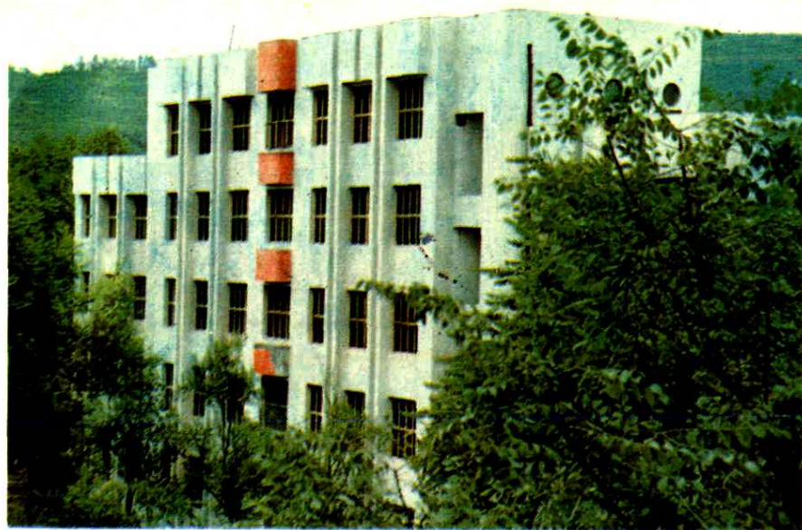
双凤中学教学大楼
