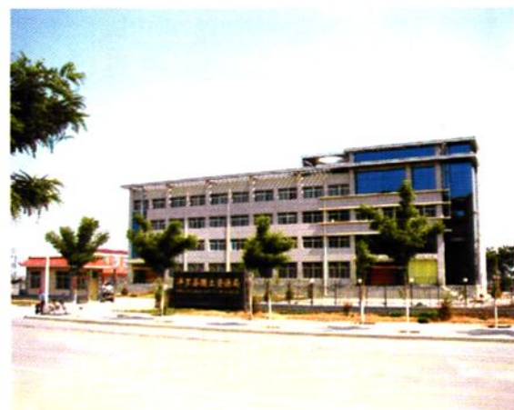
2007年12月落成的县国土资源局办公大楼
