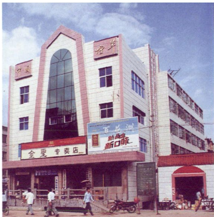
石城县烟草专卖局(公司)办公大楼
