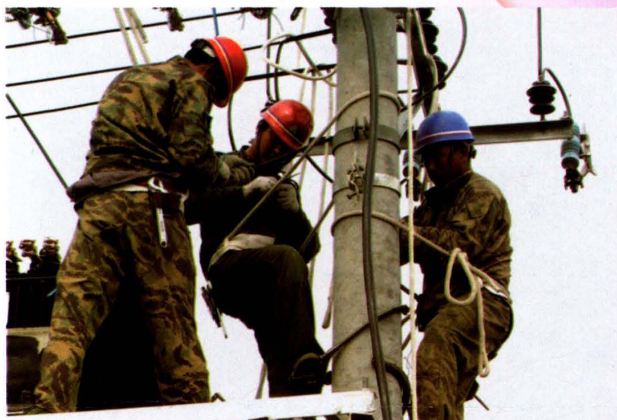
2007年5月城网改造中， 施工人员在安装变台
