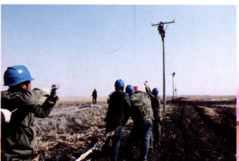
2014年3月我局长吉岗供电所组织施工人员为水田农户建设电力配套设施
