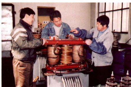
1999 年 11 月修试 所工作人 员正在修 理变压器
