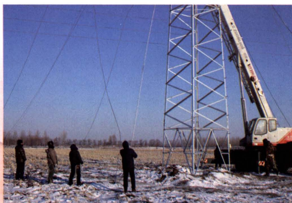
2014年12月农网改造工程中，施工人员正在组立杆塔
