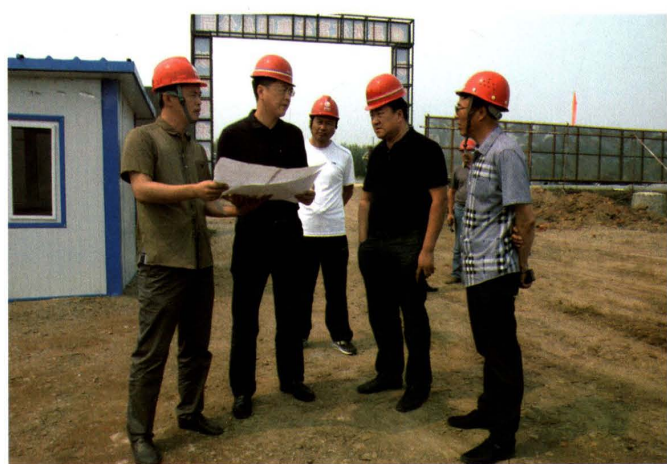
2014年7月县政府领导深入35千伏 城北变电所施工现场了解工程建设情况
