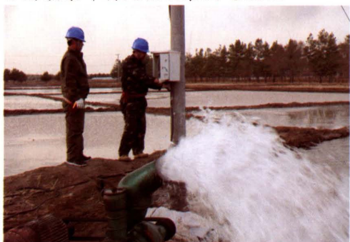
2011年5月我局生产人员义务为水田农户检修用电设施
