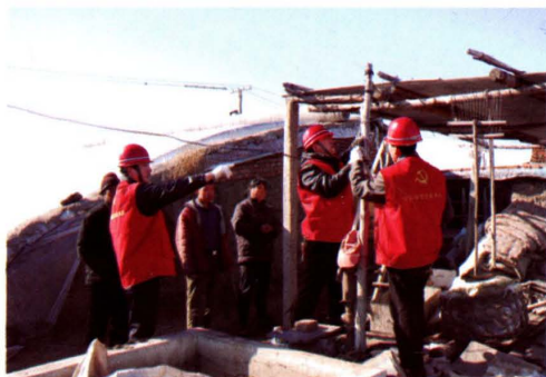
2010年3月共产党员服务队正在为甘南镇东郊村大棚安装用电设施
