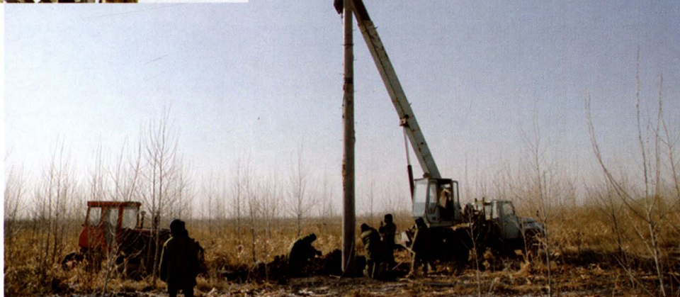
2009年 12月农网改 造中，施工人 员正在架设 35千伏线路
