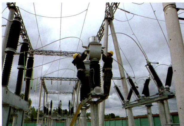
2014年5月110千伏长吉岗变电所 施工人员正在调试设备，为投运做准备
