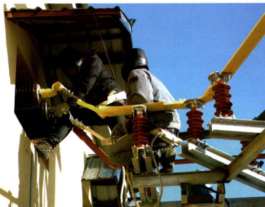
2014年12月施工人员正在安装城 北变电所10千伏母线桥
