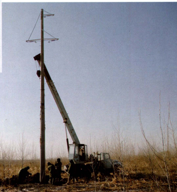
2007年5月城网改造中， 施工人员在安装变台
