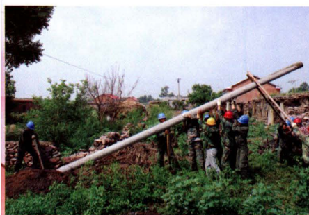
2010 年 7 月长山供电所组织人 员全力抢修被冰雹损毁的线路
