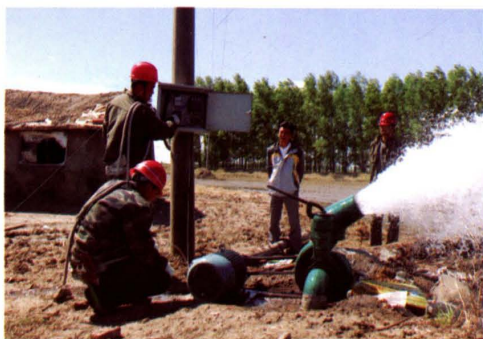
2010年5月我局音河供电所人员为水田农户安装电泵
