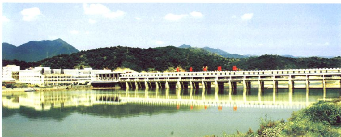
城东水闸桥电站，装机容量3x2500千瓦
