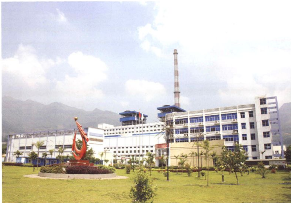
安溪煤研石火电厂，装机容量 2 \times 5 万千瓦
