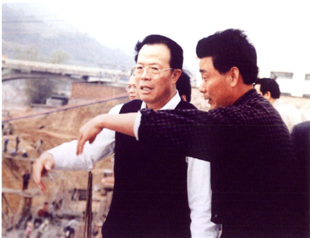
2002年11月8日，中共福建省委常委、常务副省长张家坤（左一）视察城东水闸桥电站建设工地
