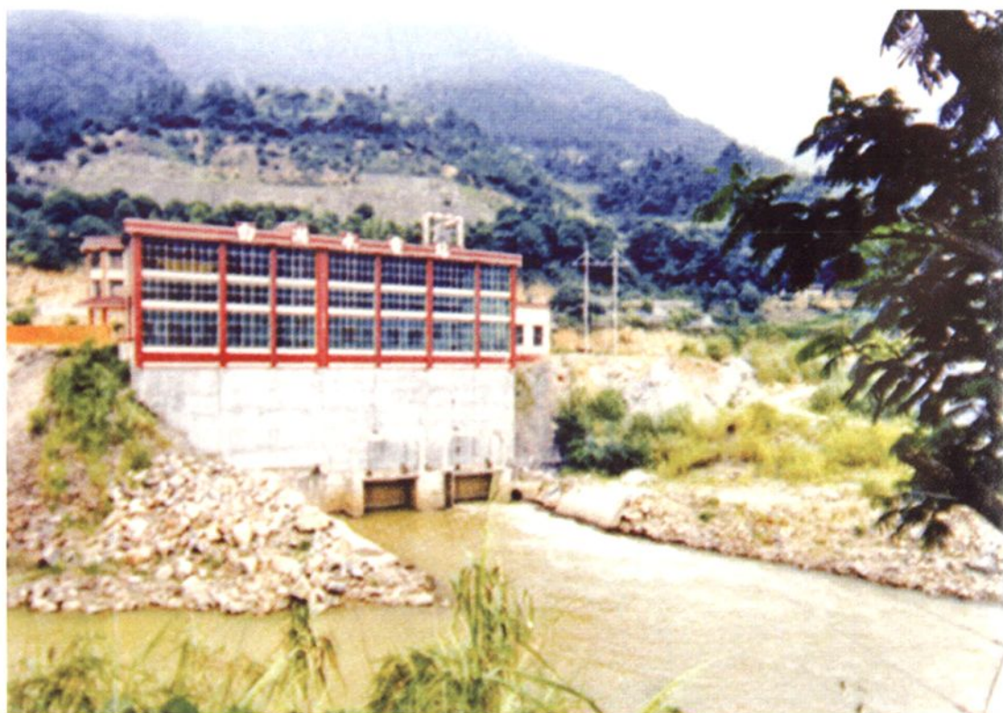
白濑一级水电站，装机容量2x1万千瓦
