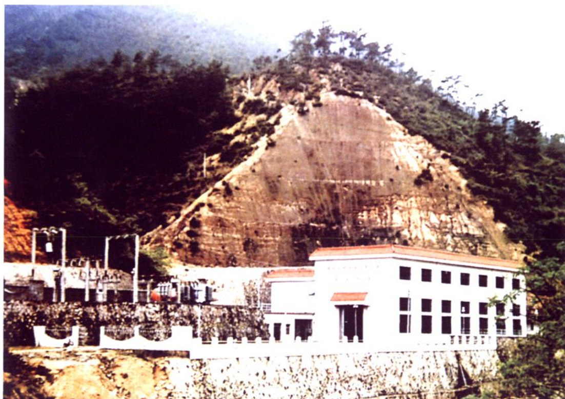
外资翰苑水电站，装机容量2x4000千瓦
