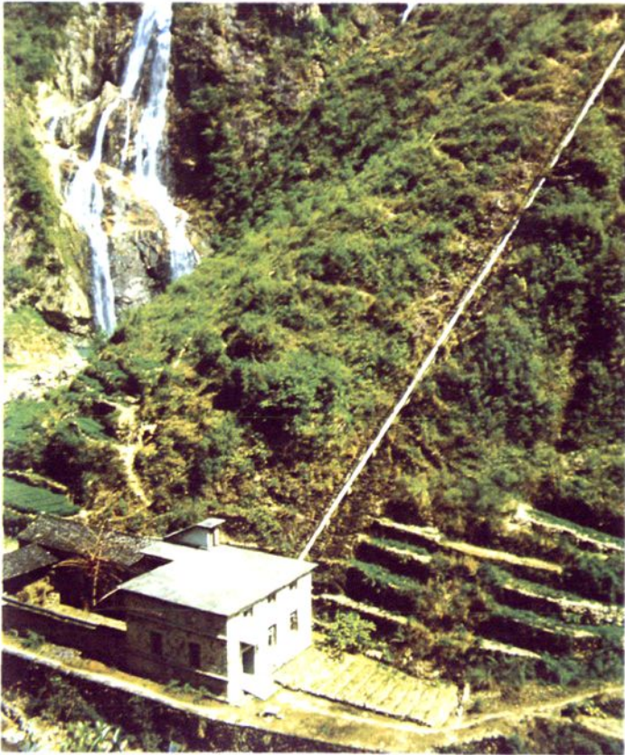
77年大坪漳州百丈磑水电站，装机容量200千瓦
