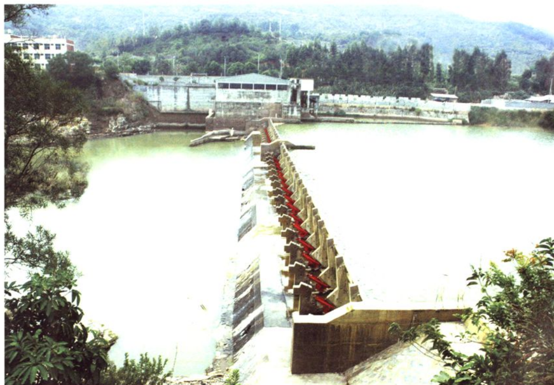
曾坑水电站，装机容量 3 \times 1000 千瓦
