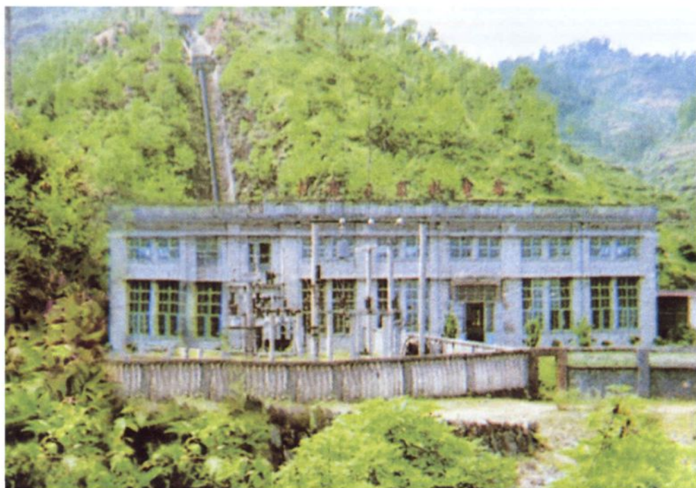
龙门村内二级水电站，装机容量 2 \times 1600 千瓦
