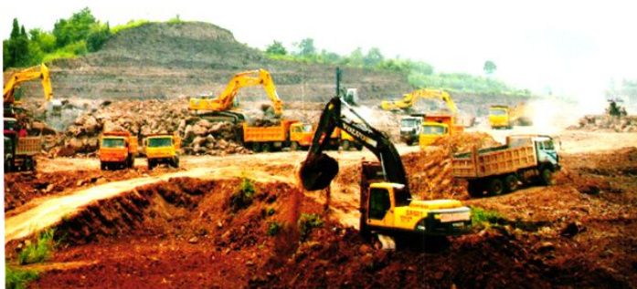
园区基础设施建设加快推进
