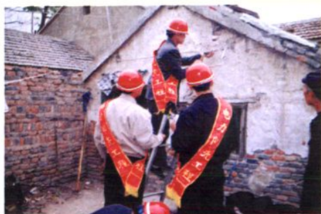
电力阳光工程服务队到居民家中维修服务
