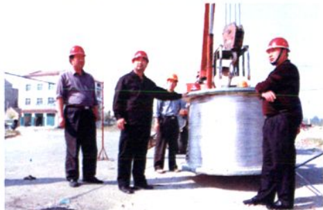
段超(中)在现场指导农村电网改造
