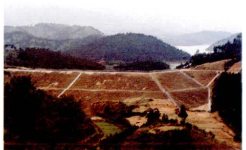
加固后的第一副坝
