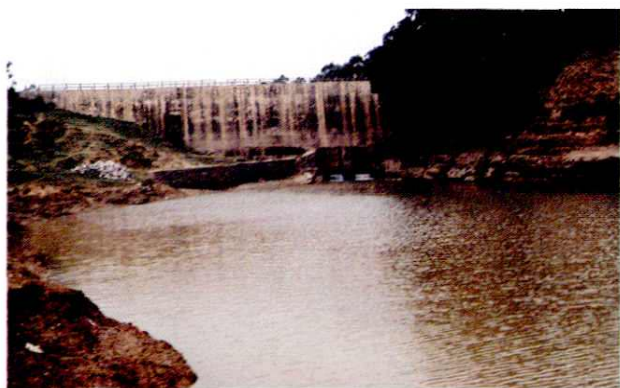
东津防洪工程—画眉堤
