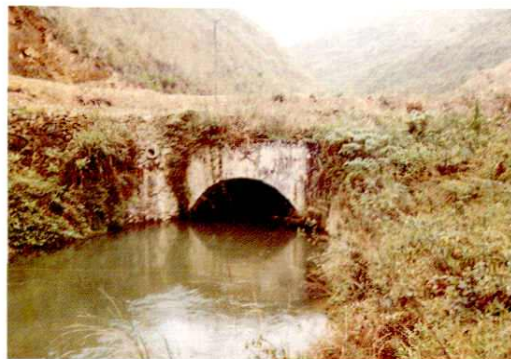
干渠分水坳第一涵洞
