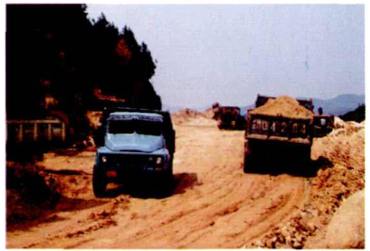
溢洪道拓宽工程正在施工中
