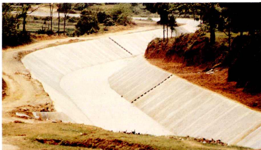
干渠三面光砼防渗工程
