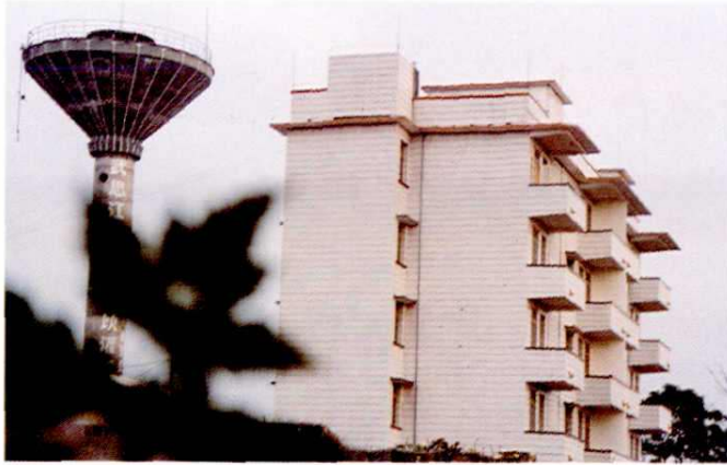
桥圩饮灌工程
