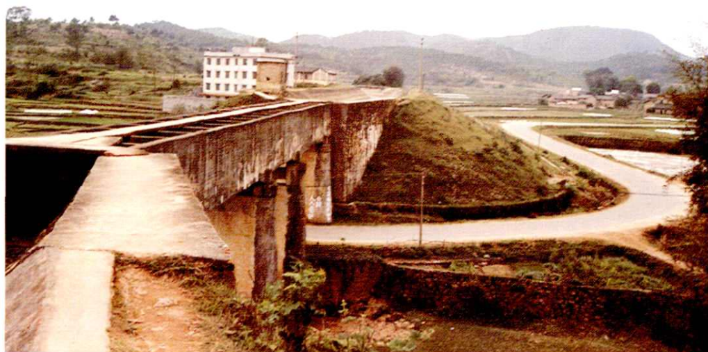
木格和尚桥渡槽
