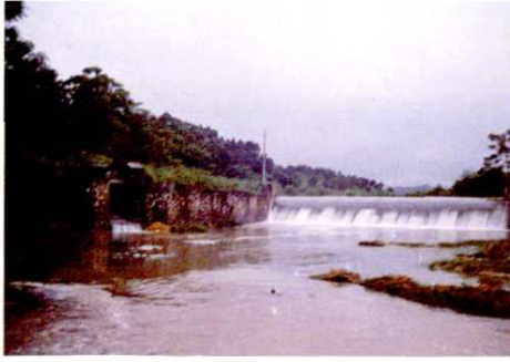
湛江坝引水工程
