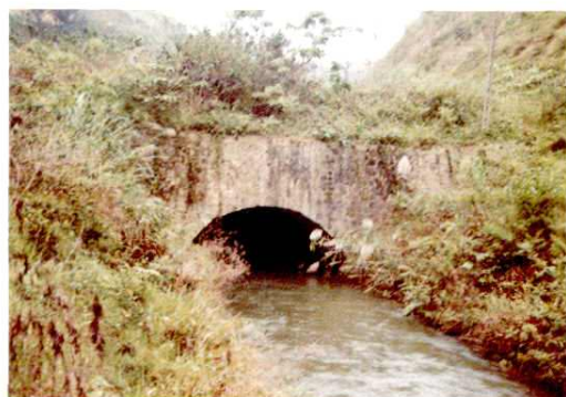
干渠分水坳第二涵洞
