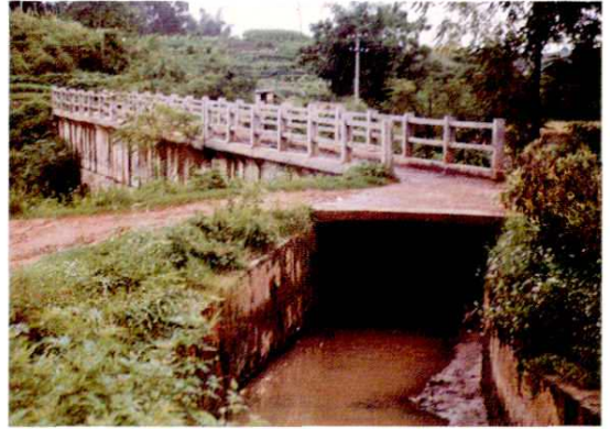
湛江坝涵洞引水桥
