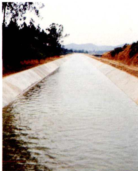
干渠三面光砼防渗工程
