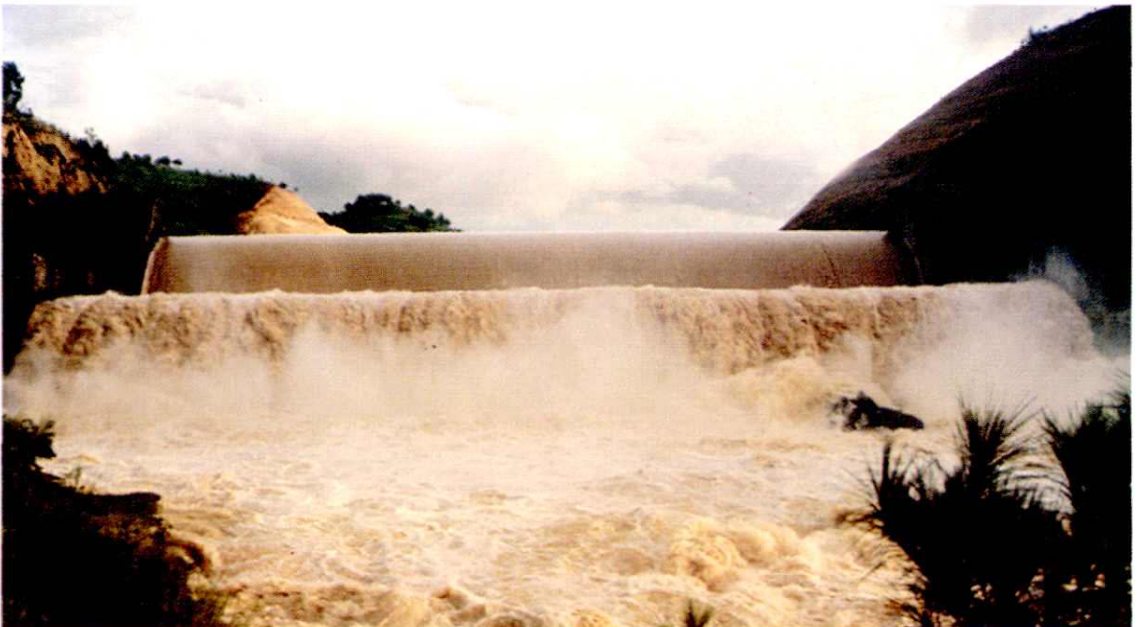
新拓宽后的溢洪道
