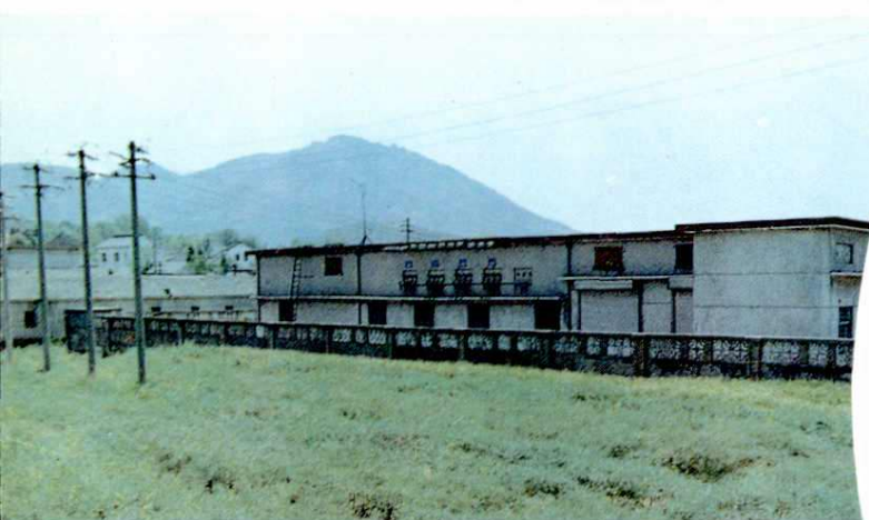
茅山老区建起 35 千伏茅山变电所
