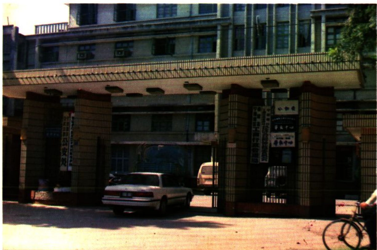
宁德地区工商局与公安处、检察院、司法局的同一办公大楼。
