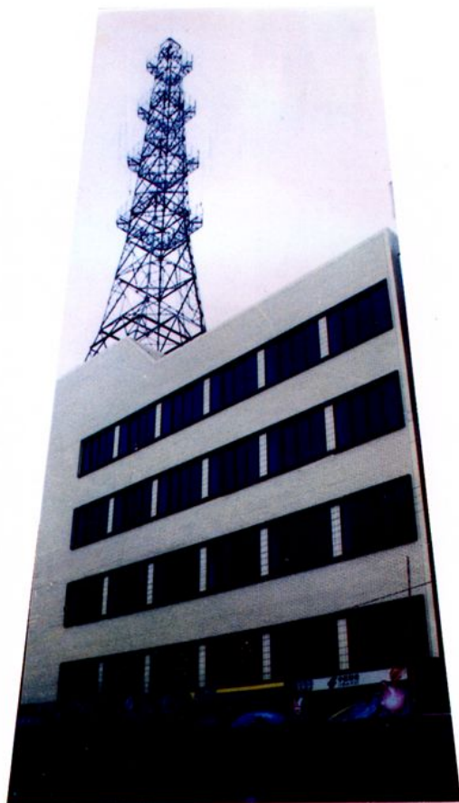
◀ 罗城邮电支局高 60.2 米的通信铁塔
