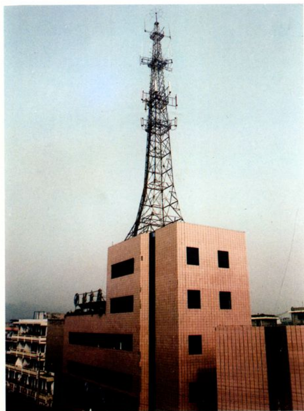
▲ 县局高66.2米的通信铁塔
