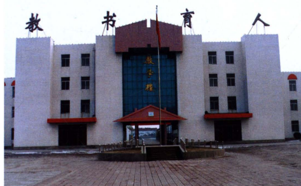
滨城区第四中学教学楼
