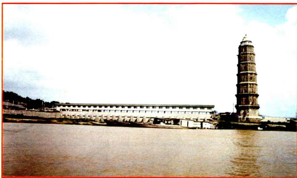
韩江北溪分洪桥闸
