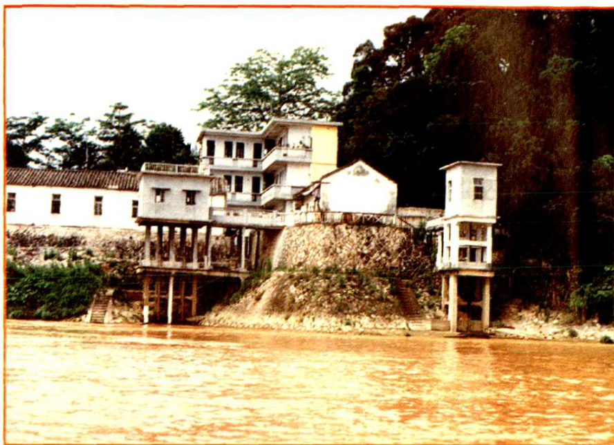
韩江北堤北关引韩灌溉工程进水闸
