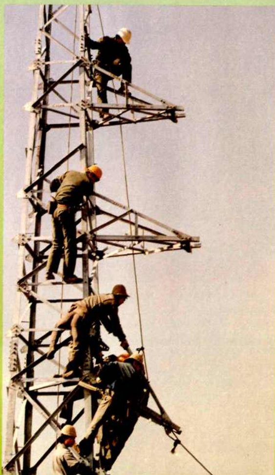
市电气安装公司架线
