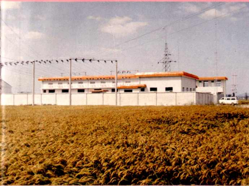
35 千伏马镇变电所
