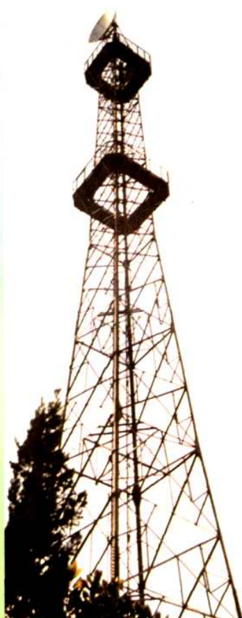
沪徐微波电路江阴中继站微波塔
