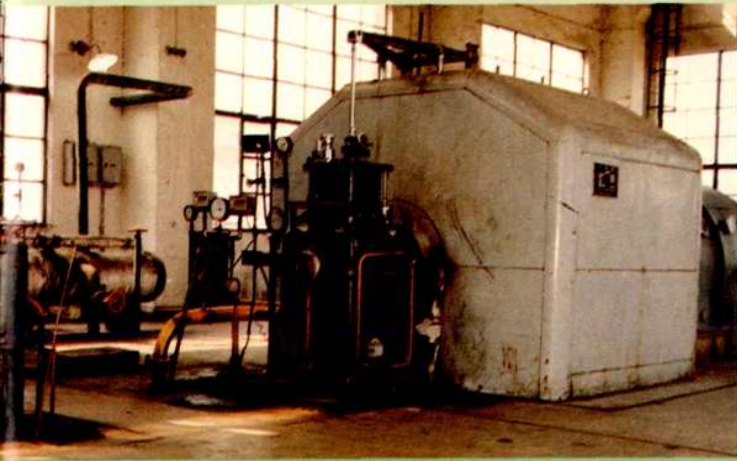
江阴印染厂余热发电机组
