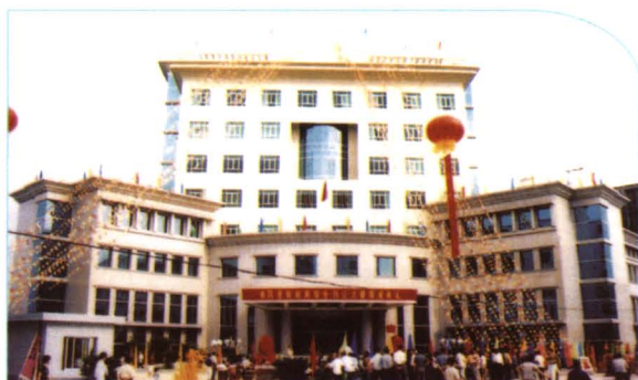
▲ 佛冈县财政局办公大楼，由佛冈县建筑工程设计室设计，佛冈县泰康建筑安装工程有限公司承建
