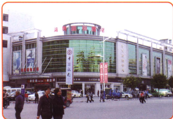
▲ 时代购物中心位于县城振兴北路与建设路交汇处，由佛冈县建筑工程设计室有限公司设计，佛冈县弘大建筑安装工程有限公司承建，2006年竣工
