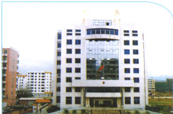
▲ 位于县城振兴中路的佛冈县检察院办公大楼
