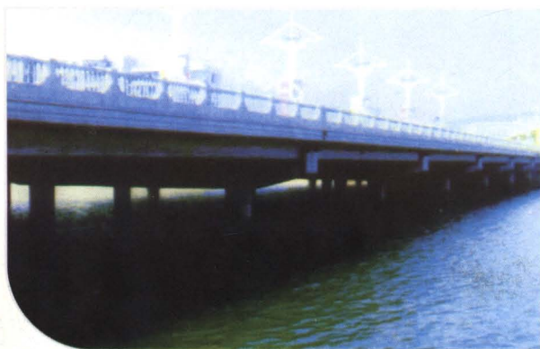
▲ 佛冈县城湖滨大桥是县城中心轴线重点工程，建成于2003年3月
