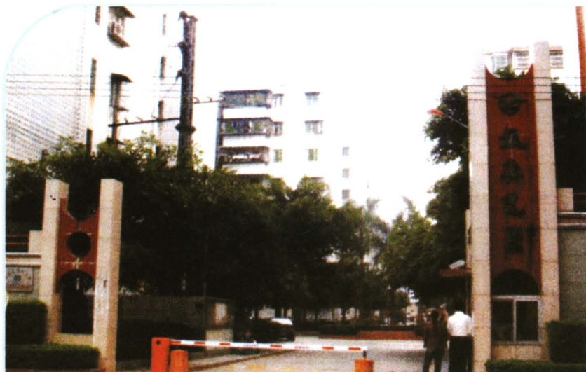
◀ 振兴花园位于县城振兴路, 1997年起由佛冈县建筑安装工程公司与广州冶金公司联合开发, 是佛冈境内第一个花园式住宅小区
