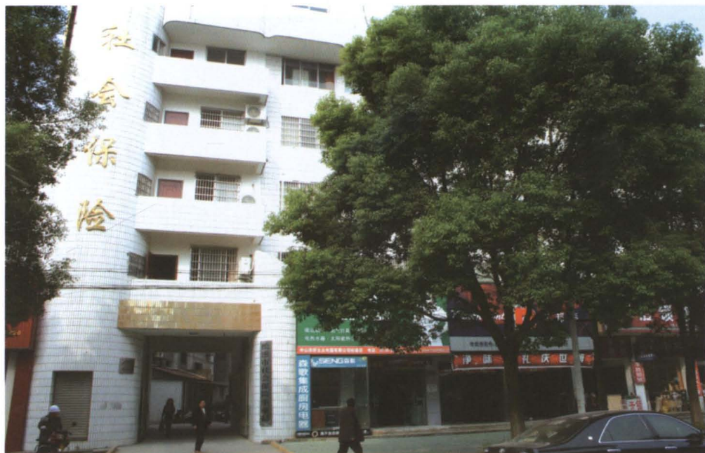
松滋市社会保险事业局办公大楼
