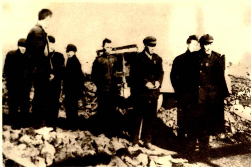
韶关地、市委领导 在韶关钢铁公司炼 焦工地检查工作。
