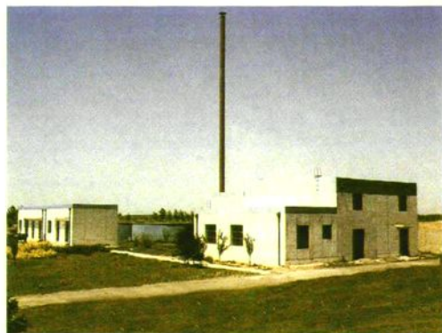
榆堡小城镇自来水厂、锅炉房
