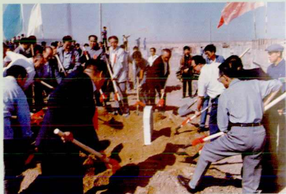
1990年能源部副部长史大桢视察银川新城变电所
