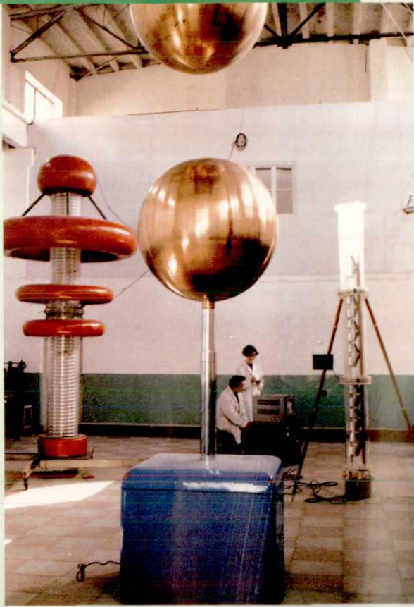
银川电力修造厂测试大厅
