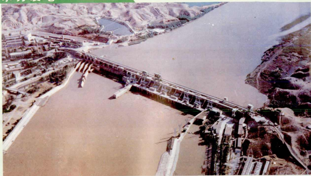
青铜峡水电厂鸟瞰
