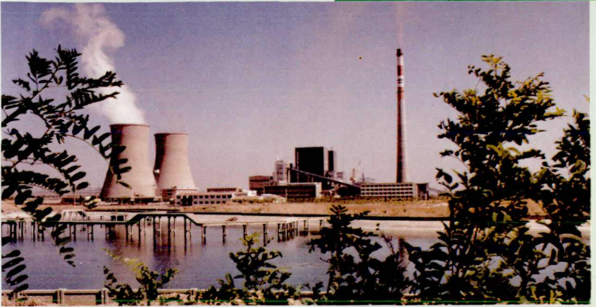
建设中的大坝发电厂
