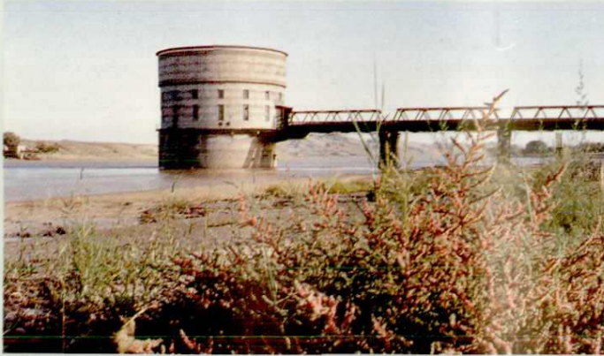
石嘴山发电厂河心水泵房获水利电力部优秀设计奖
