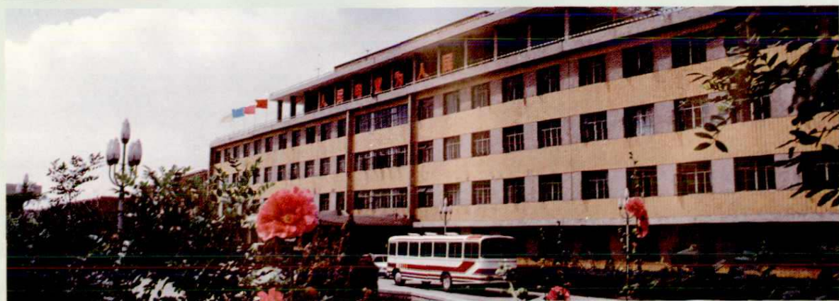
宁夏电力局办公大楼
