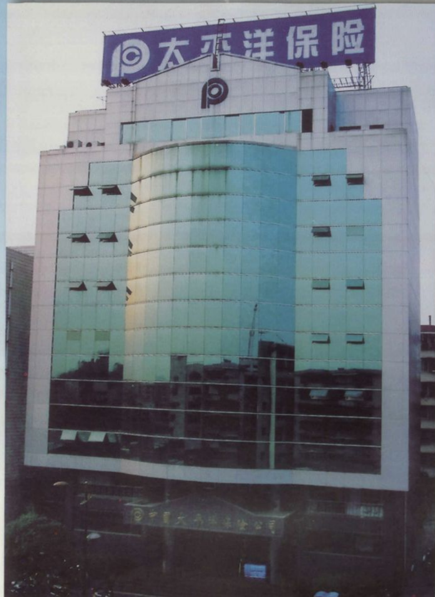
◀ 太平洋保险公司 桂林分公司办公大楼 外景。1至4层为太保 (寿险)桂林分公司办 公室,5至8层为太保 (产险)桂林分公司办 公室。
