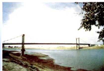
齐德哈仁大桥
