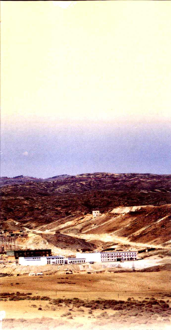
正在建设中的国家级大型铜矿 ——阿舍勒铜矿
