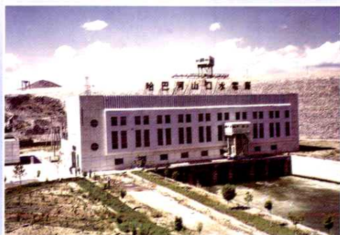
1998年9月26日，山口水电厂竣工
