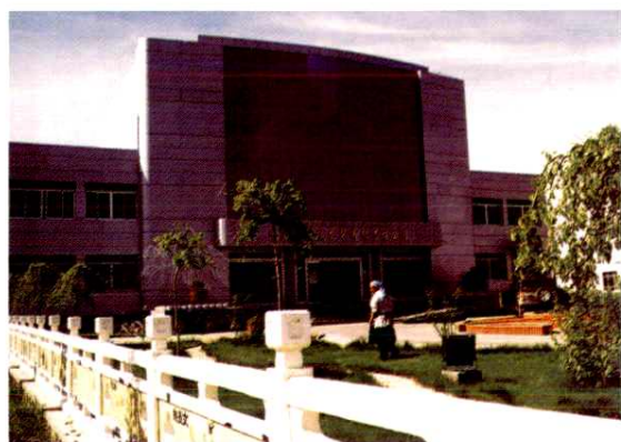
1999年建筑安装有限责任公司办公楼竣工
