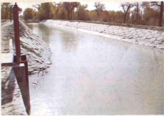
水泥预制板防渗干渠
