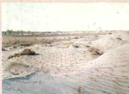
网格化固沙工程
