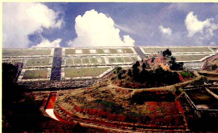
大佛水库大坝
