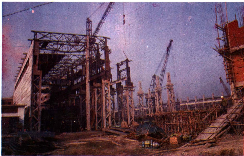
建设中的 15 吨转炉车间
