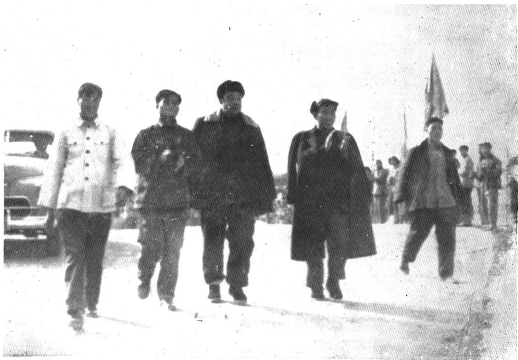
一九六〇年，中央领导同志与来金参加全国小水电会议的代表，由金华地委书记李学智陪同参观义亭人民公社小水电建设，和岩口水库施工情况。公社党委书记王正燮，副书记吴汝恭前往迎接。
