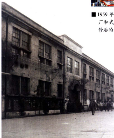
■ 1926年建造的南洋汉口烟厂(今硚口仁寿路182号)主厂房,沿用至20世纪90年代初
