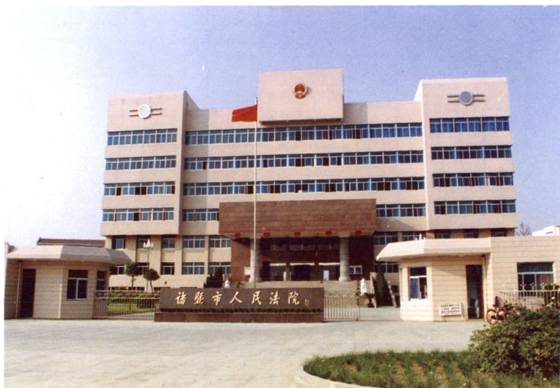
诸暨市法院办公楼
