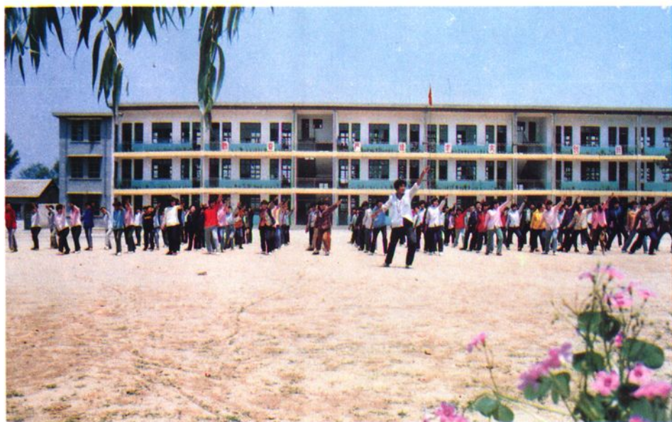
滕州市第二十一中教学大楼。
