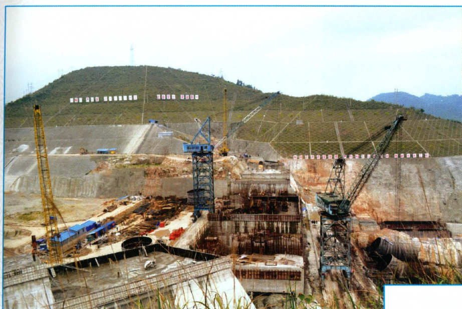
▲ 建设中的托口水电站
