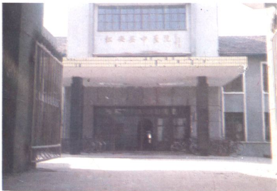
红安县中医院门诊楼
