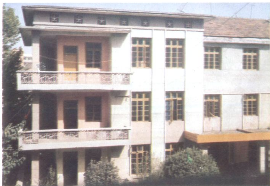
红安县卫生局办公楼
