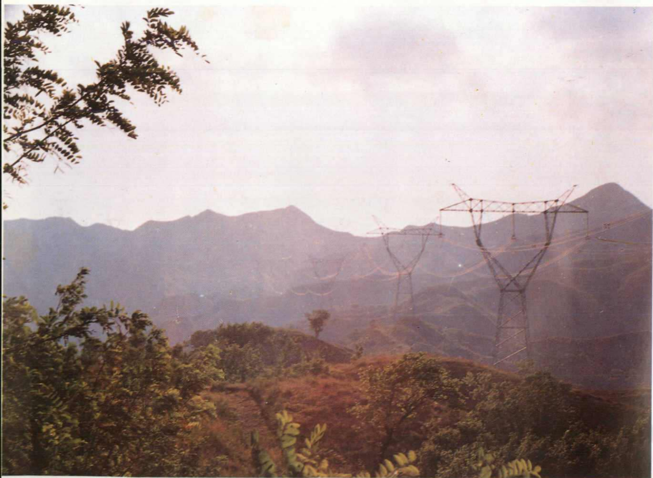
超高压500千伏线路跨越太行山
