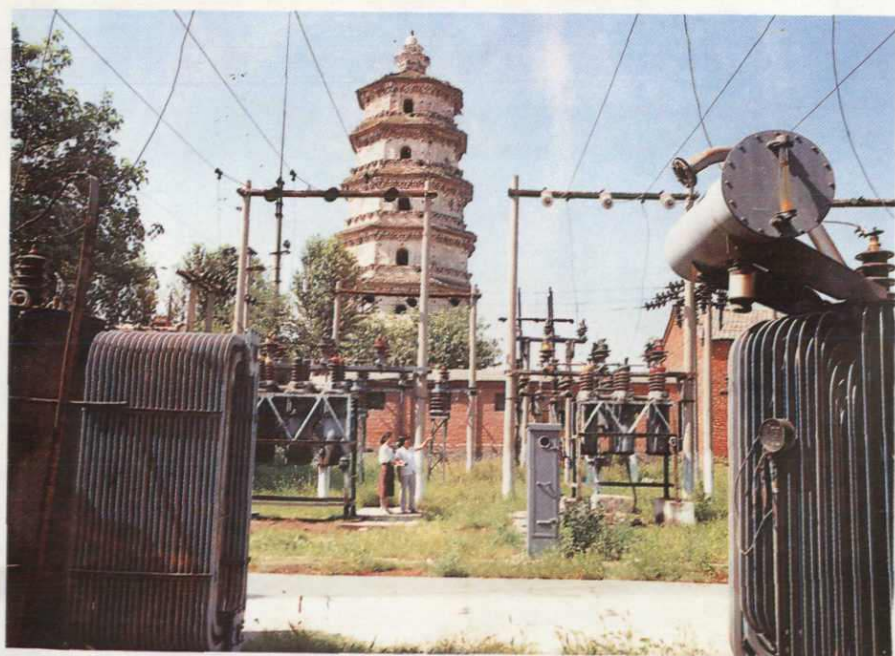
1950年建成的保定地区第一座35千伏变电站——涿县变电站
