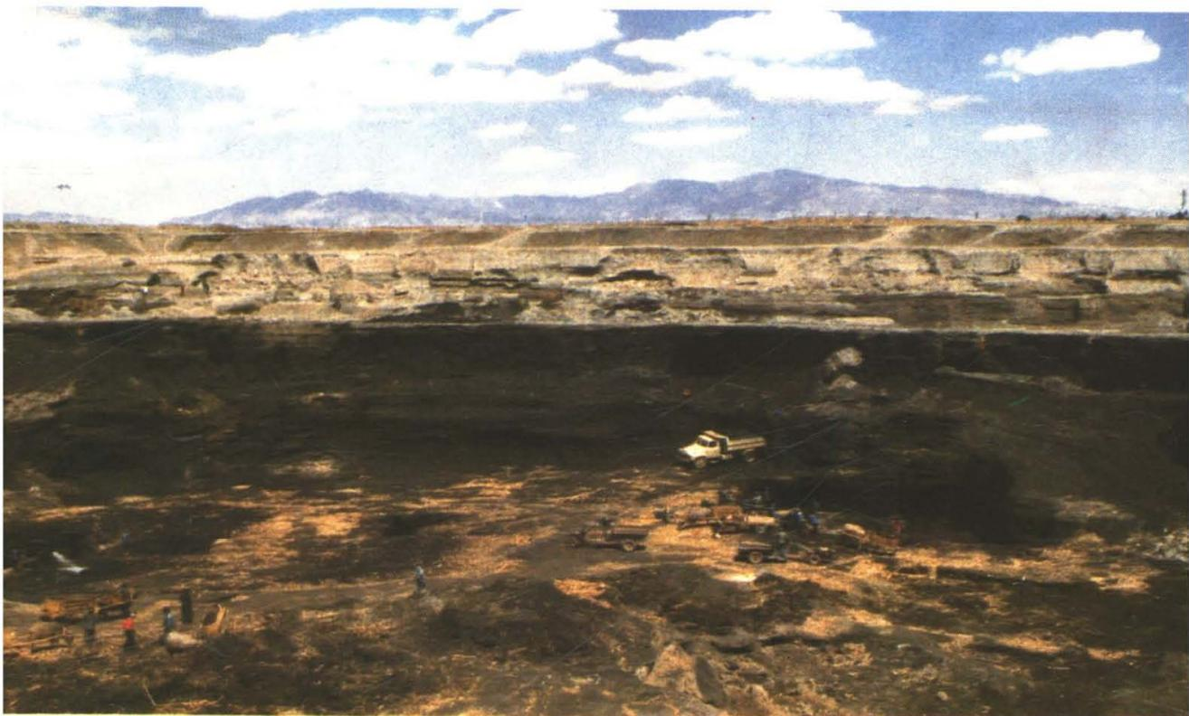
▲ 褐煤开采 昭通市褐煤储量达80亿吨，居全国第二位。煤层既厚又平缓，表土较薄且松软，构造比较简单，宜于露天开采。
