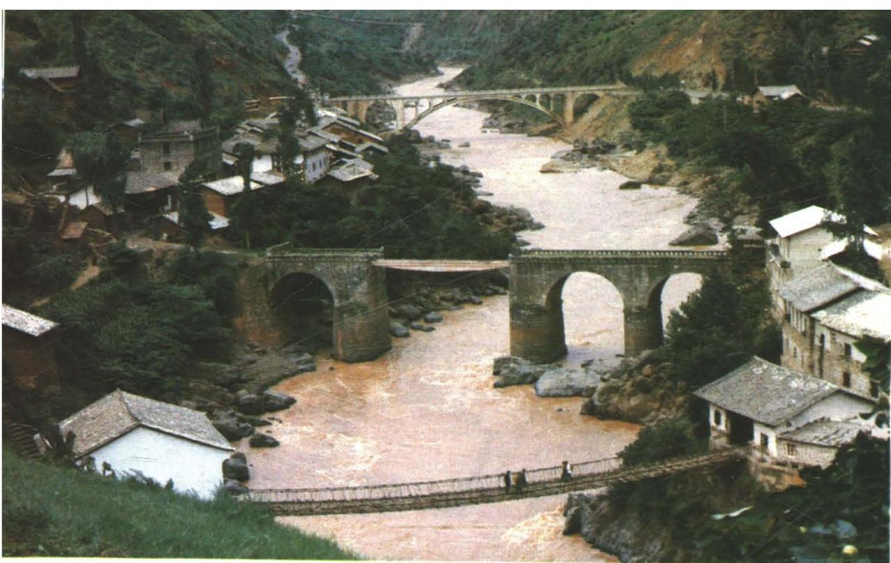
▲ 江底三桥 鲁甸县大水井区江底镇，隔牛栏江与会泽县相望，自古是交通要道。原有人马吊桥，后修了公路桥，近年又新建双曲拱公路桥。一镇建三桥，反映了交通运输的巨大变化。
