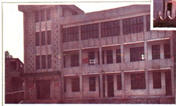
◁ 县教师进修学校办公楼
