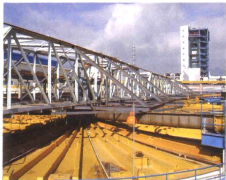
制液车间浸出一隅
