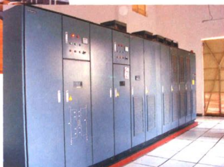
焙烧排烟机高压变频技改
