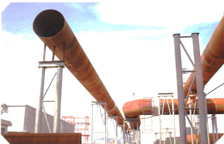
2004年9月,硫酸锌系统干吸管道安装。
