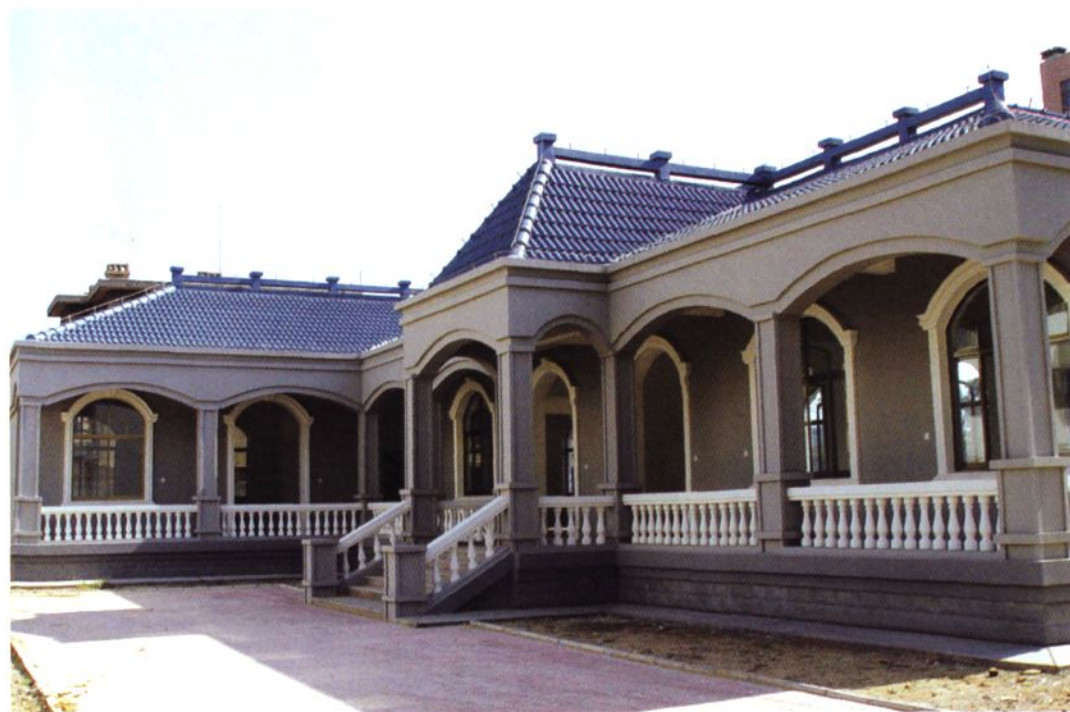
潍坊监测中心台
