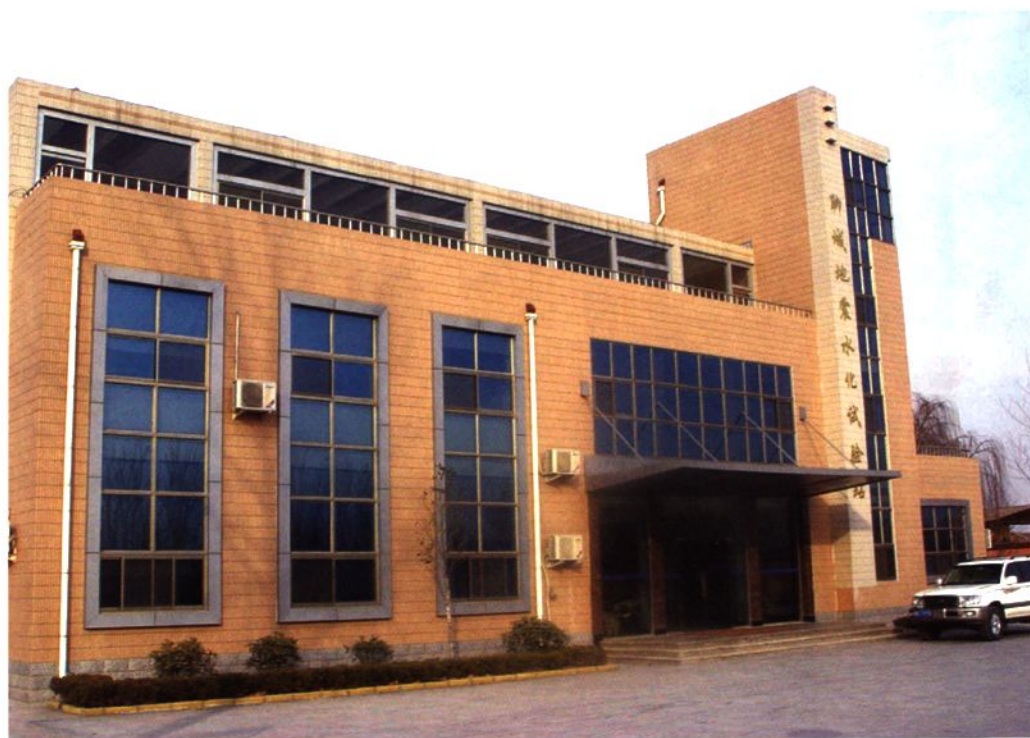
聊城地震水化试验站
