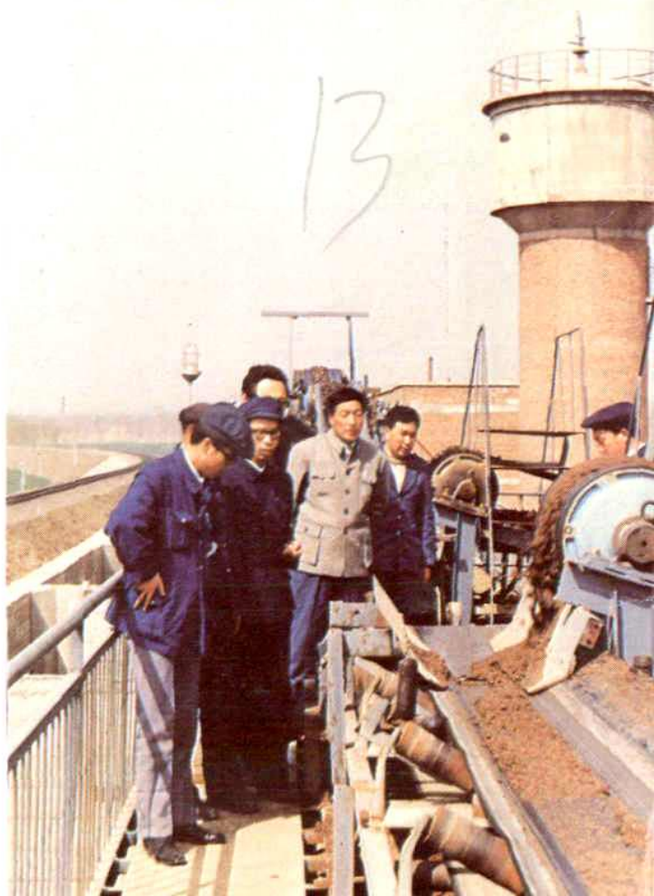
铁道部工务局工处处韩起 孟(左一) 在临汝采石场检查工作
