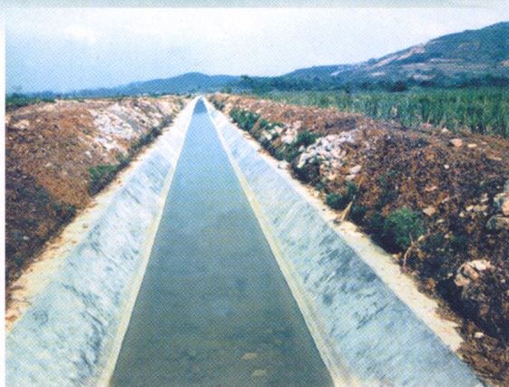
渠道防渗后的牛仔滩泵站南干渠
