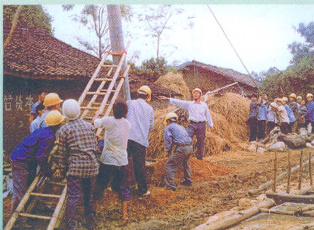
农村电网改造工程
