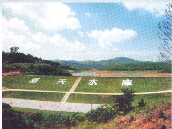
除险加固后的派关水库
