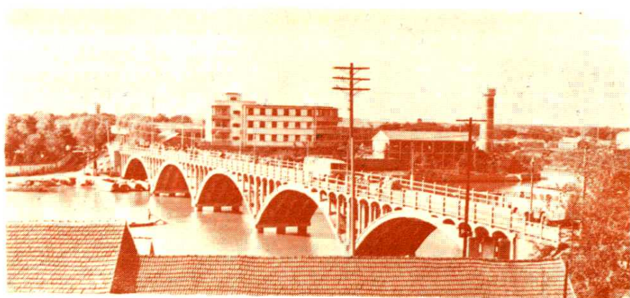
上冈镇北大桥
