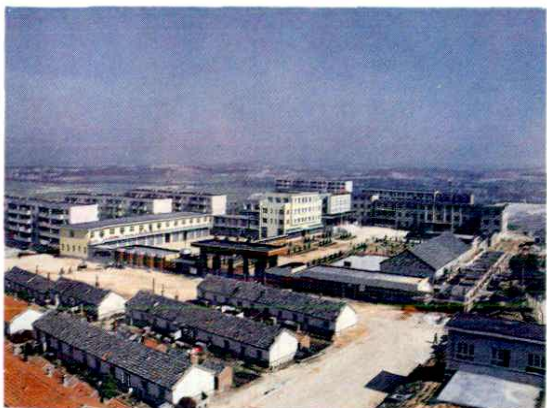
年产黄金万两以上的地方国营乳 山县金矿厂区一角
