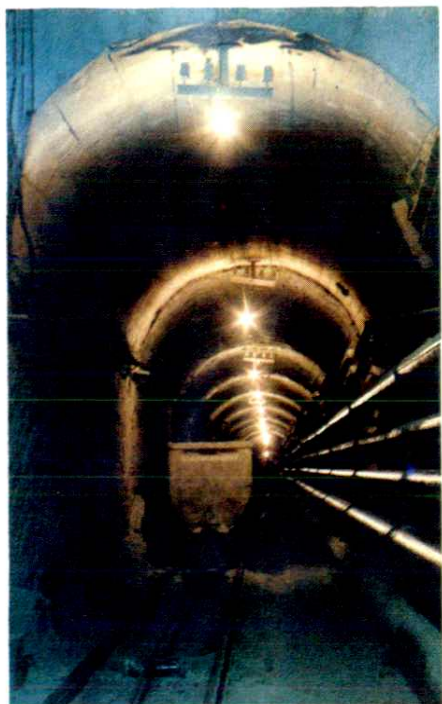
新城金矿的斜井
