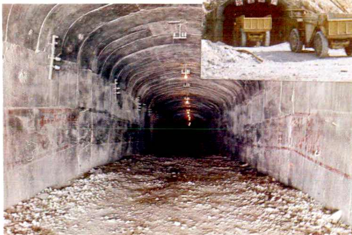
三山岛金矿的斜坡道（净断面为15.67平方米），重型卡车可直驶井下采场
