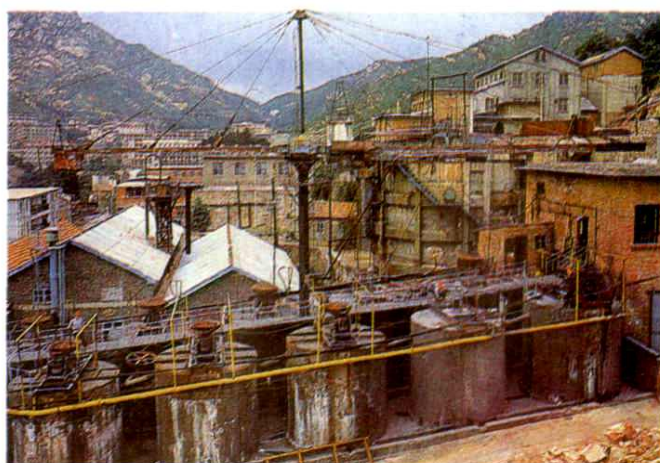
招远金矿玲珑选厂氰化车间一角
