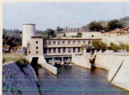
沂南县岸堤水电站是山东省最大的水电站，1971年11月动工建设，至1981年4台水轮机组全部建成投产，共5350千瓦。
