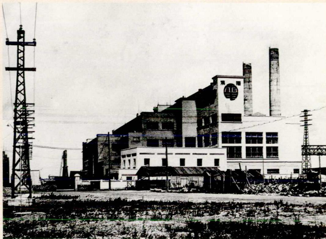
1934年建设的青岛四方发电所，安装1台1.5万千瓦机组，1935年12月1日建成投产，正式对外供电。
