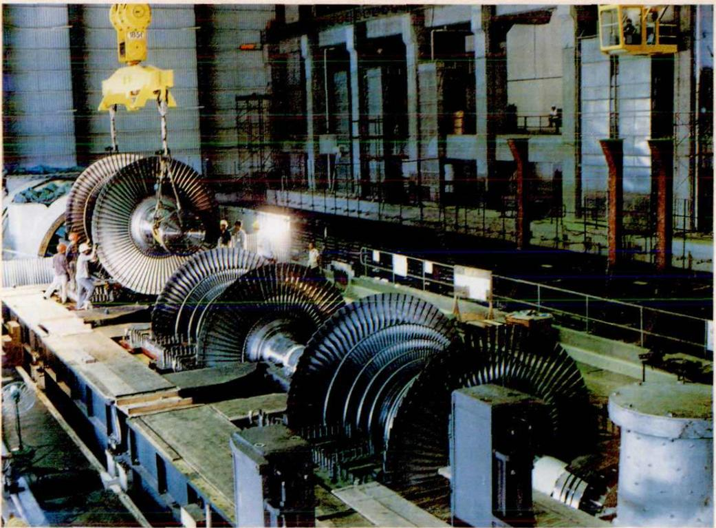
山东核电工程公司安装广东大亚湾核电站90万千瓦汽轮机
