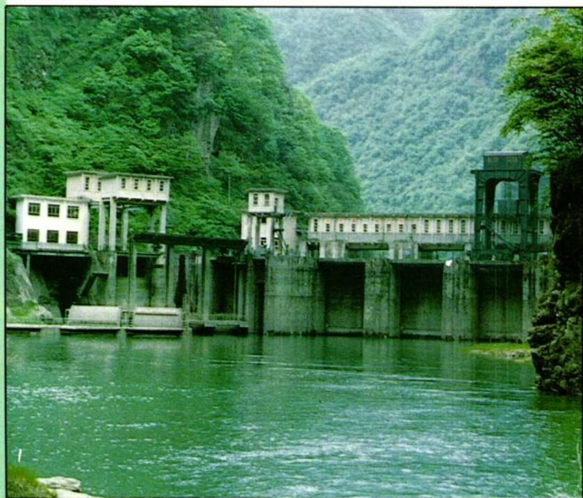
省属渔子溪电站水闸
