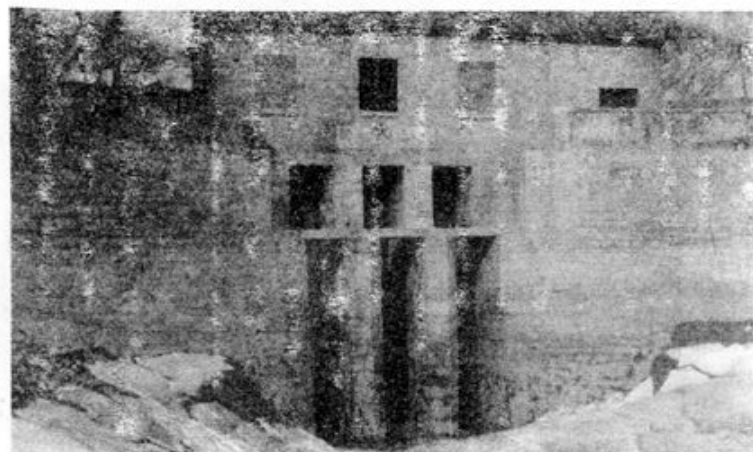
22、北金堤明堤涵闸
