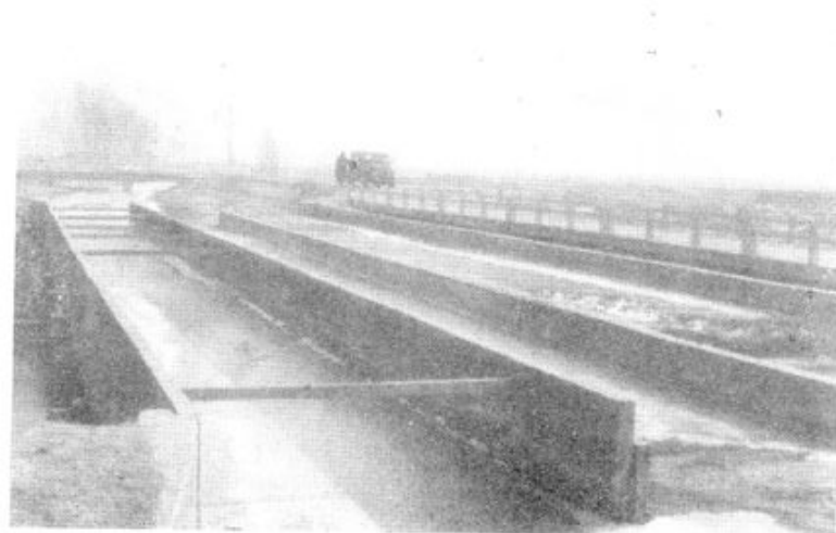
18、小运河郎湾渡槽
