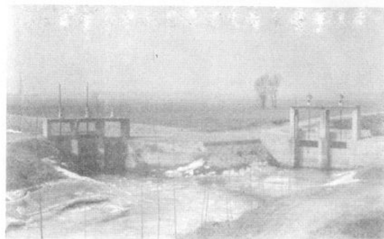
10、明堤干渠王堤分水闸
