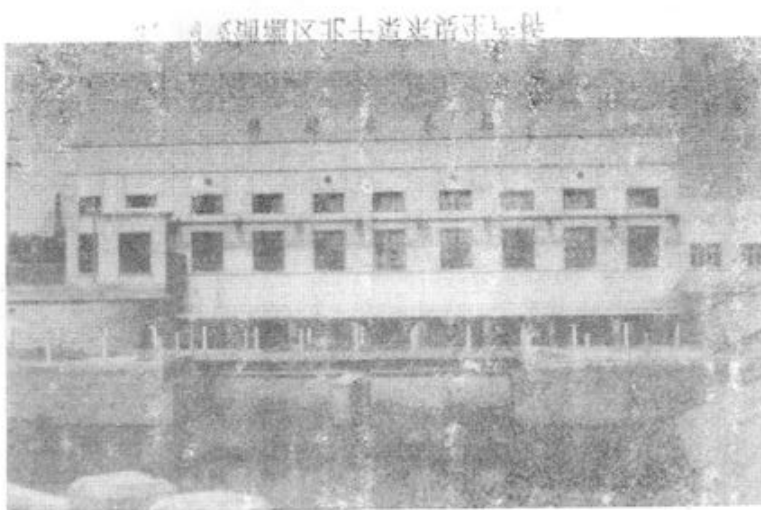
5、陶城铺北干渠骆驼巷泵站
