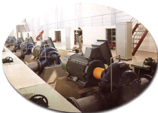
铁西水厂供水泵房
