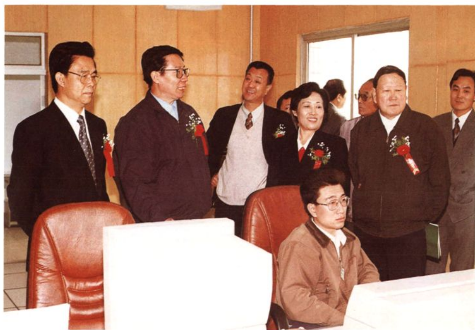
市领导在铁 西水厂视察主控 室
