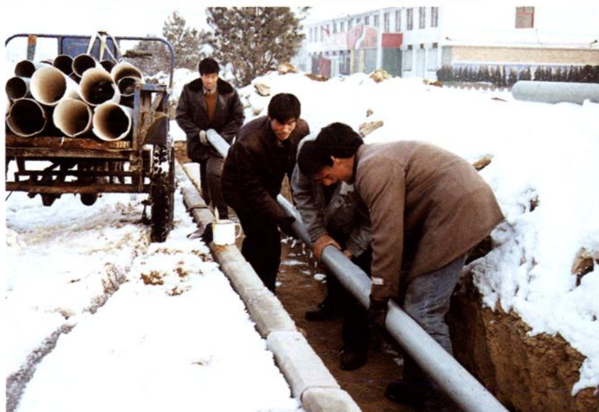
人民路中水喷灌工程紧张施工
