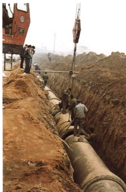
引岳济邯供水工程管道辅装
