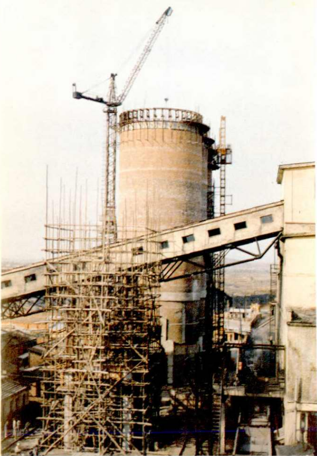
采用滑模施工新工艺建设的圆筒煤仓
