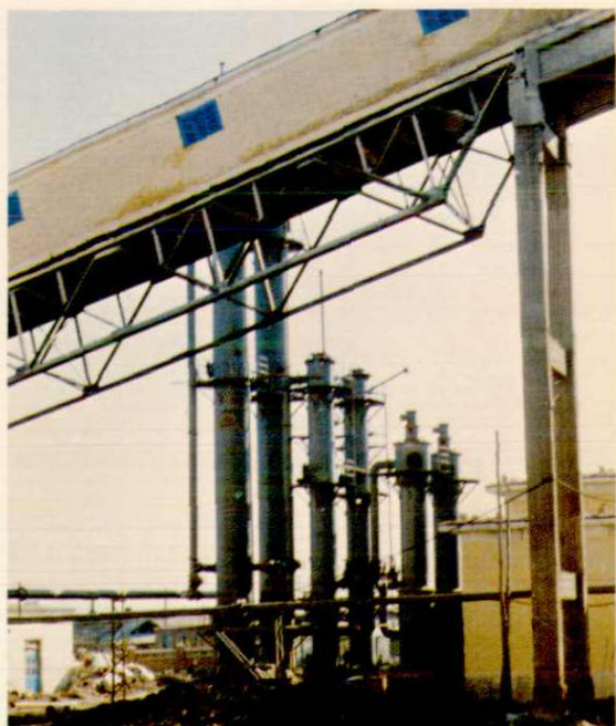
煤气厂的煤气净化系统
