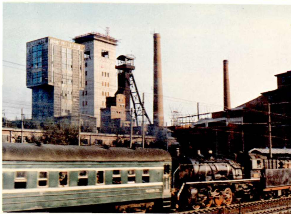
由我国自行设计和 施工的南山煤矿竖井
