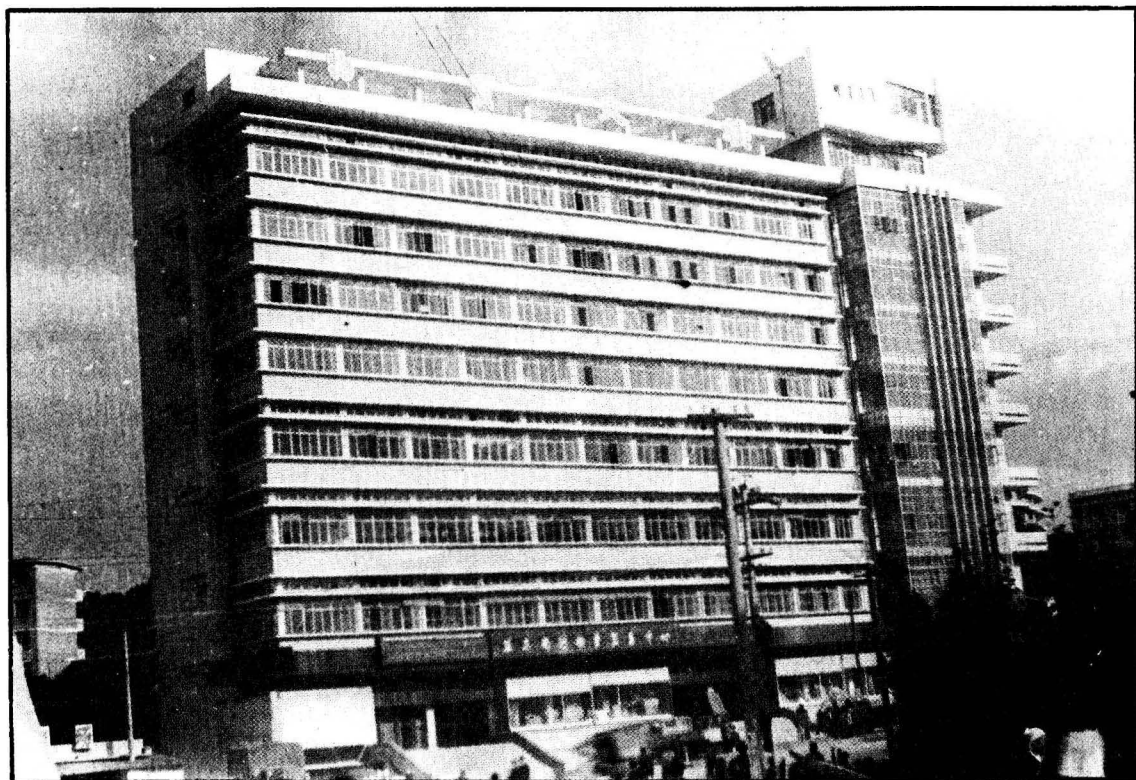
黔东南州物资贸易中心大楼
