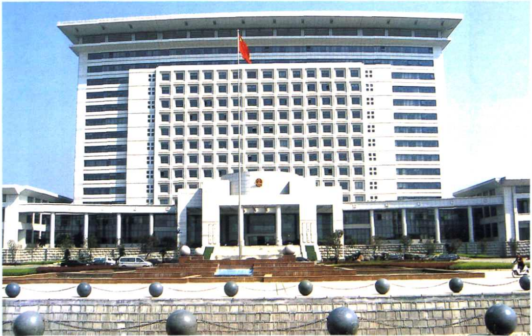
鄞州新城区惠风东路区政协新址
