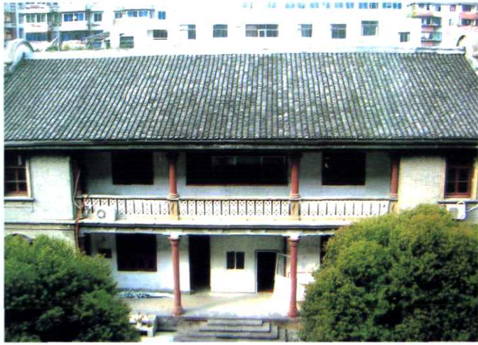
鄞州区政协 虹桥巷旧址
