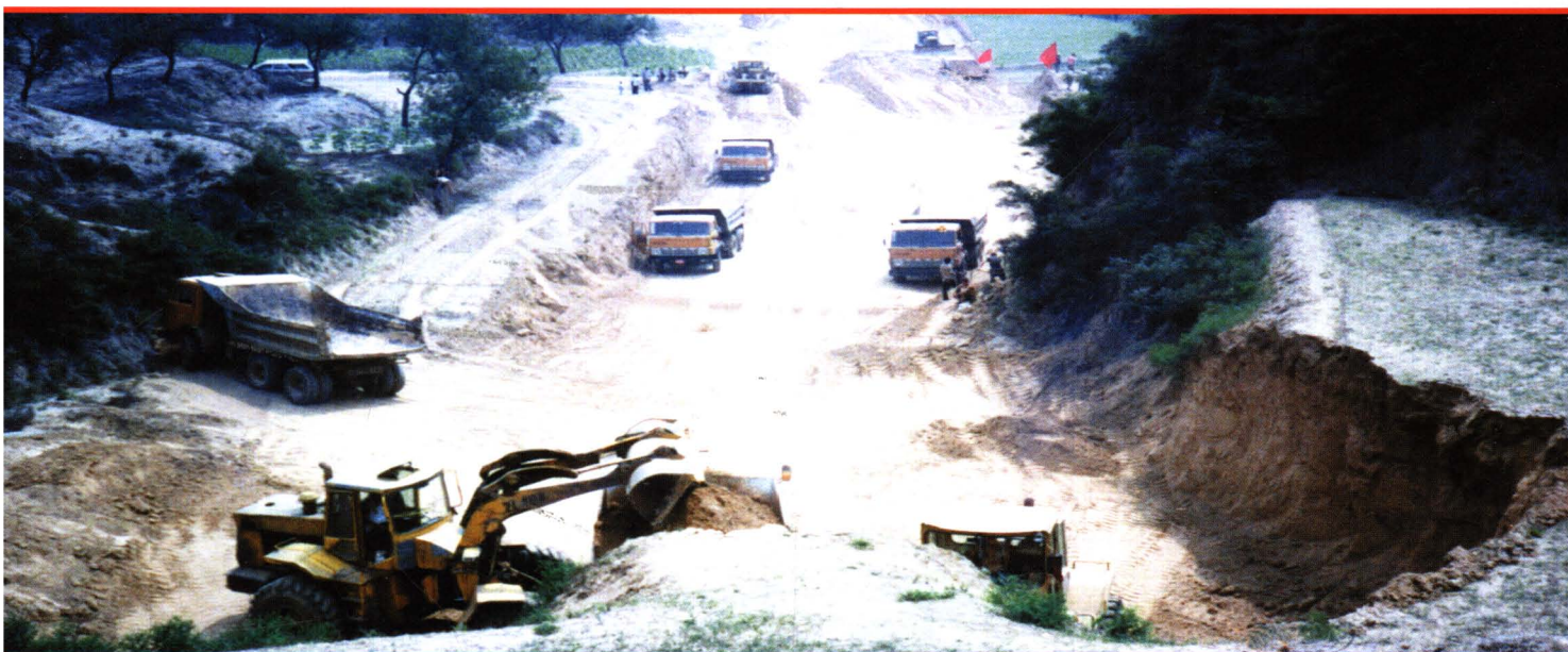
孝午公路施工现场
