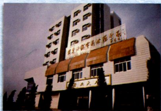
波阳分局办公大楼 1996年竣工，1997年6月投入使用
