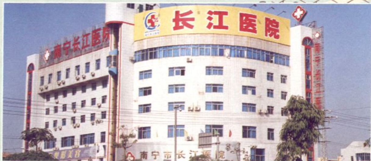
▲万秀村第一村民小组综合楼（长江医院）
