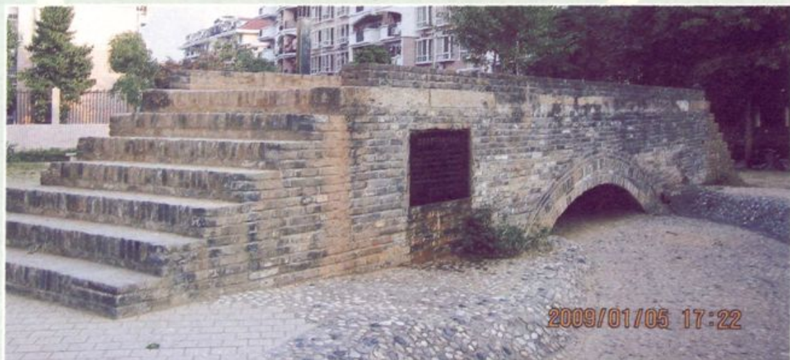
▲万秀村第六条横跨朝阳溪的邓姓坡“佛子桥”（复原）
